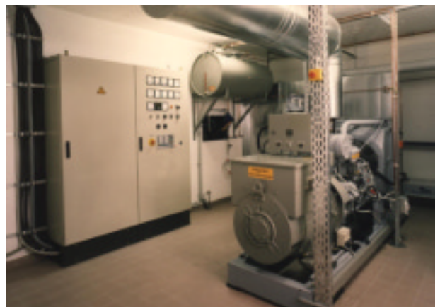
Bild 1: Notstrom - Dieselaggregat
