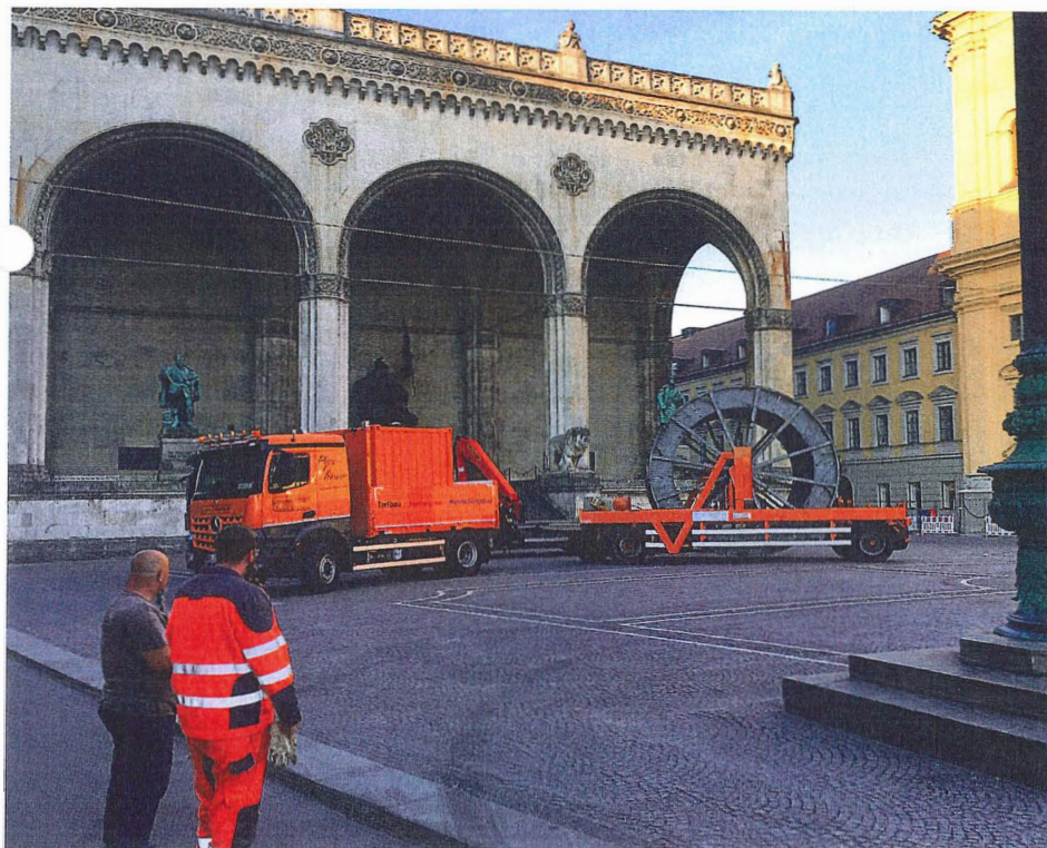
In der Stadt München werden in der Altstadt gelegene Gebäude nach und nach an das Fernwärmenetz angeschlossen. Aufgrund der schwierigen Bedingungen war eine besonders flexible Lösung gefragt. Diese lieferte die Brugg Rohrsystem AG mit dem Fernheizkabel FLEXWELL.
