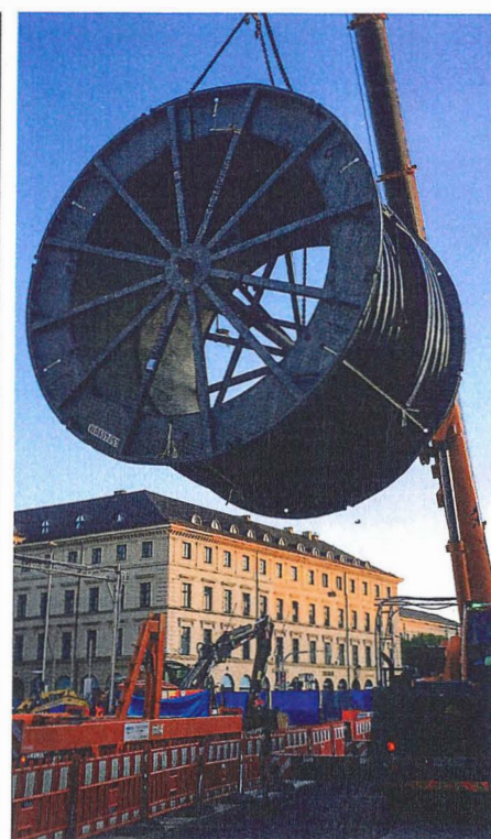
In der Stadt München werden in der Altstadt gelegene Gebäude nach und nach an das Fernwärmenetz angeschlossen. Aufgrund der schwierigen Bedingungen war eine besonders flexible Lösung gefragt. Diese lieferte die Brugg Rohrsystem AG mit dem Fernheizkabel FLEXWELL.
