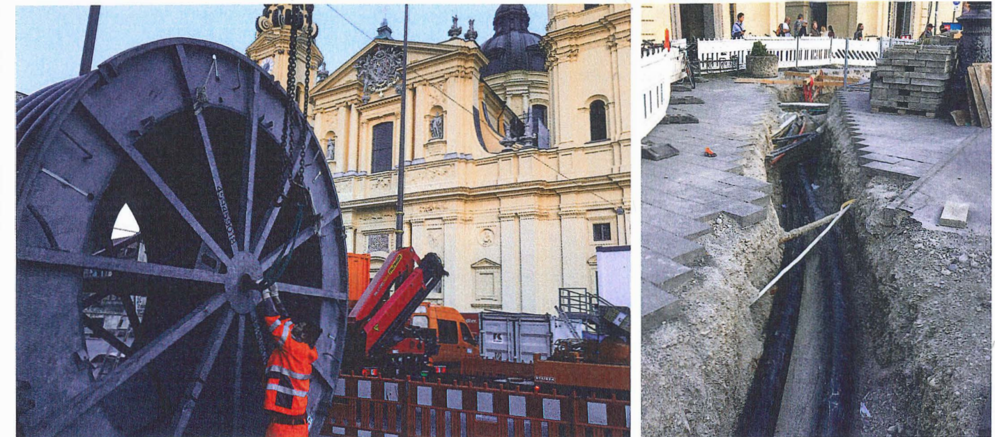
Das FLEXWELL Fernheizkabel lässt sich direkt an der Baustelle auf die gewünschte Länge bringen. Aufgrund seiner Flexibilität stellen auch enge Platzverhältnisse kein Problem dar: Es kann einfach zwischen bereits verlegten Kabeln ohne zusätzliche Elemente «hindurchgefädelt» werden, sodass die Bauzeit erheblich reduziert wird.
