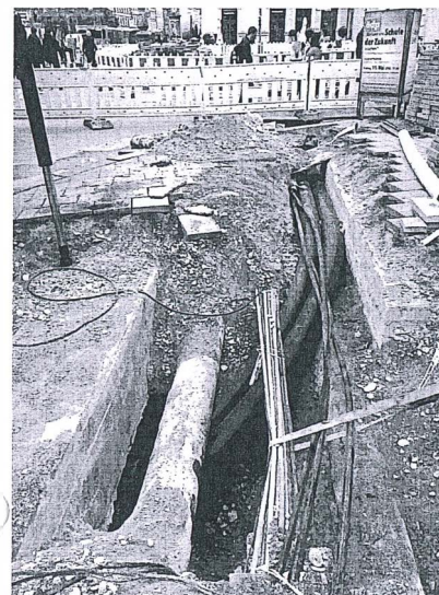
Dank der Flexibilität von Flexwell stellen auch enge Platzverhältnisse kein Problem dar. Es kann einfach zwischen bereits verlegten anderen Leitungen «eingefädelt» werden, sodass die Bauzeit erheblich reduziert wird.
