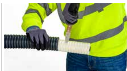
5 Dämmung über die Länge (X, Y, Z) zurückschneiden/entfernen. Achtung: Mediumrohr nicht verletzen!
