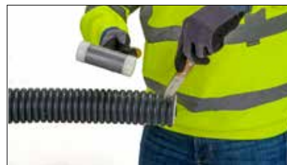
3 Mantel längs aufschneiden. Messer max. 5 mm tief einstecken. Achtung: Mediumrohr nicht verletzen!
