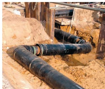
BRUGG-STAMANT®-Sicherheitsrohr mit Montage-Dehnungselement
