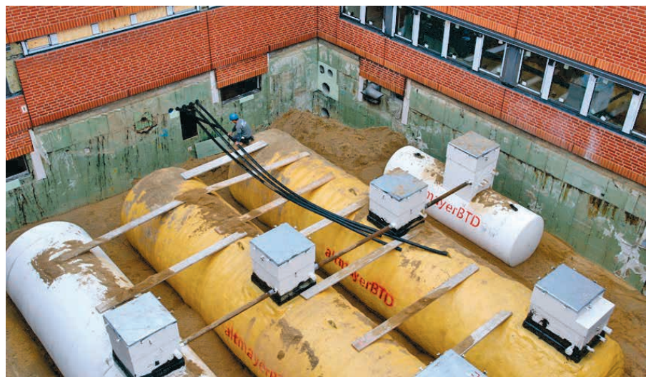
Die Tanks wurden mit einem 100-Tonnen-Kran über das 4-stöckige Gebäude hinweg in den Innenhof gehoben
