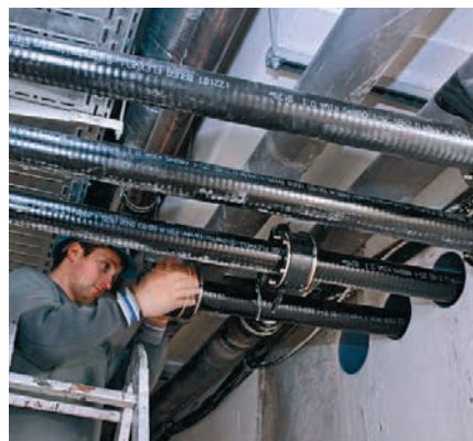
Durchgehende Verlegung ohne Verbindungsnähte vom Füllschacht bis zum Tank
