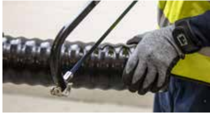
2. Mantel mit Säge am Umfang durchtrennen.
