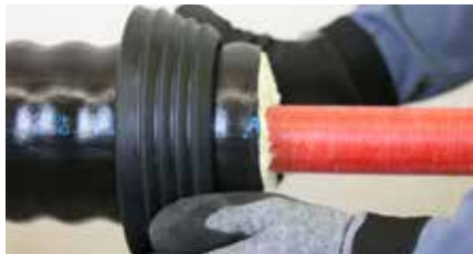
8. Mauerdichtring montieren.
