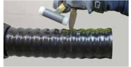
3. Mantel längs aufschneiden. Messer max. 5 mm tief einstecken.
