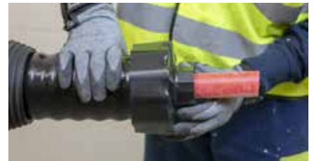
9. Schrumpfendkappe gemäss beiliegender Montageanleitung montieren.
