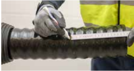
1. Mantel im Abstand (x/y) +1 cm vom Rohrende anzeichnen.
