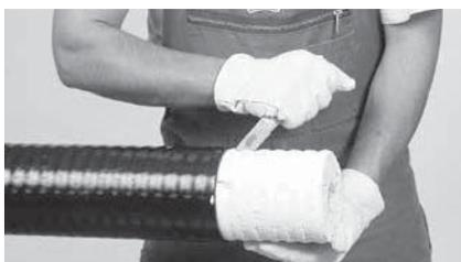
5 Dämmung über die Länge (X, Y, Z) zurückschneiden/entfernen.
