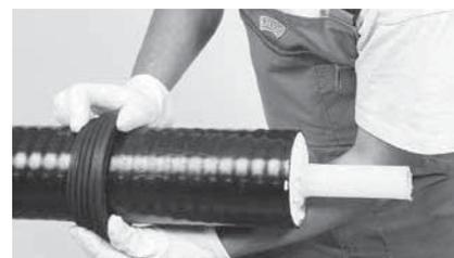
6 Mauerdichtung montieren.
